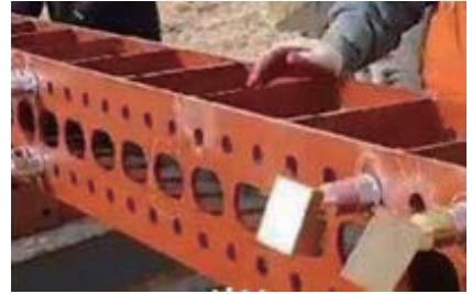
보강재 공장 제작으로 인건비 절감 및 공기 확보
